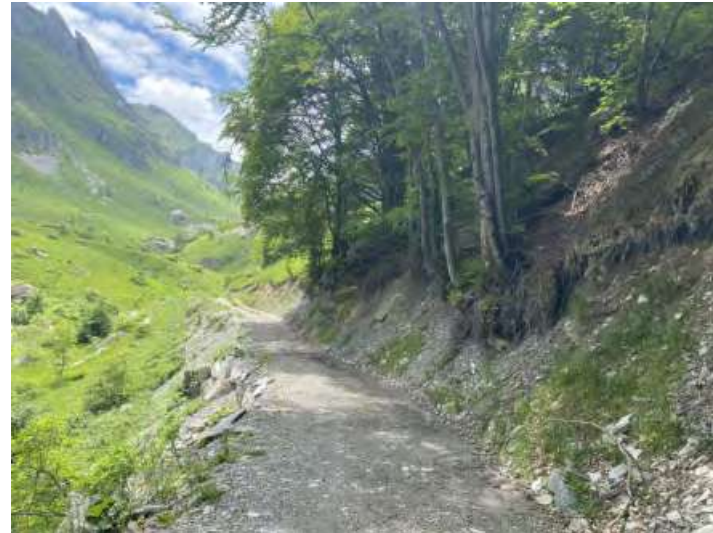
002 Tratto di pista inghiaata di revcente realizzazione
