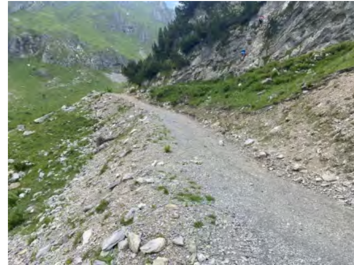
003 Tratto di pista inghiaata di revcente realizzazione
